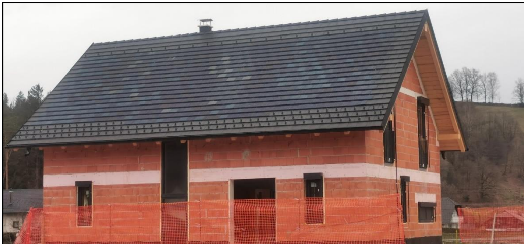
Slika 18: Primer postavitve enostanovanjske stavbe s fotovoltaičnimi moduli v vplivnem območju kulturnega spomenika v kraju Legen pri Slovenj Gradcu. (Vir: ZVKDS, 2023).
