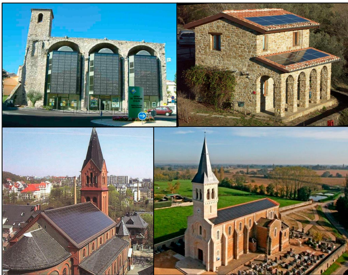
Slika 20: Primeri neustrezno umeščenih fotovoltaičnih sistemov na stavbah kulturne dediščine. (Vir: Flavio Rosa, 2020).
