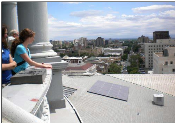
Slika 30: Fotovoltaične plošče na stavbi Denver Capitol (ZDA). (Vir: National Renewable Energy Laboratory, 2011).
