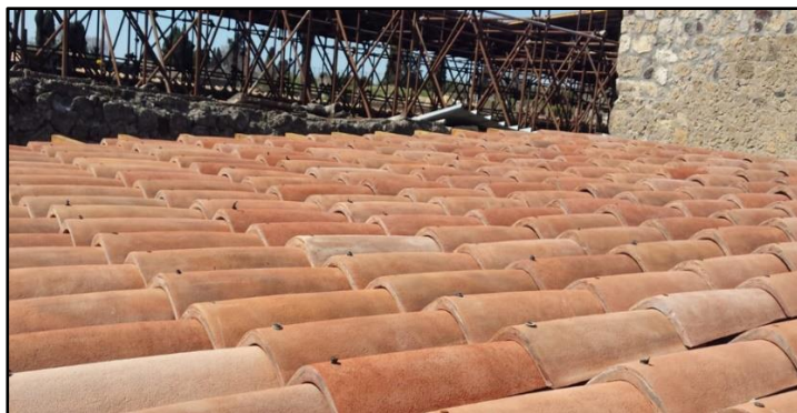
Slika 29: Montaža fotovoltaičnih strešnikov Tegola v mestu Evora (Portugalska). (Vir: Georgios Tsoumanis, 2021).
